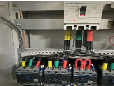
办公楼水机空调定时改造前
