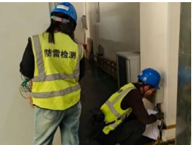
用电部位安全全面检测
